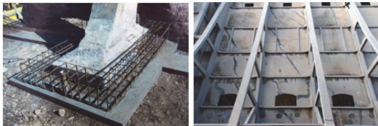
写真7 基礎補強工事
