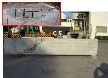
図 5 CFRP 補強梁の破壊状況
