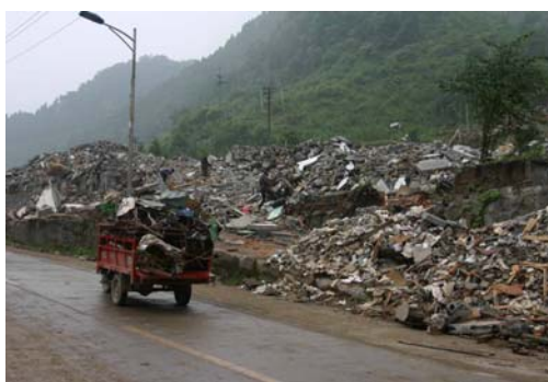
写真1 紅白鎮の被害
