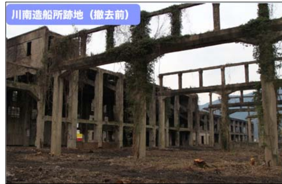
図4 撤去される前の戦争遺産的建造物
