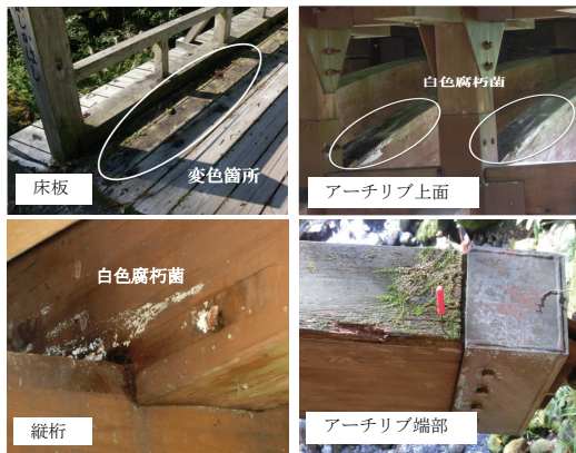
図4 目視試験による腐朽個所の一例
