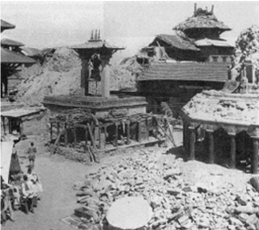
図2. 1934年ビハール・ネパール地震によるパタン王宮広場の被害
