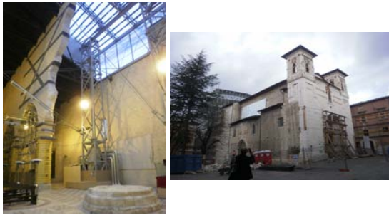
写真 4 経過措置が行われて活用されているコレマジオ教会(13世紀末)
