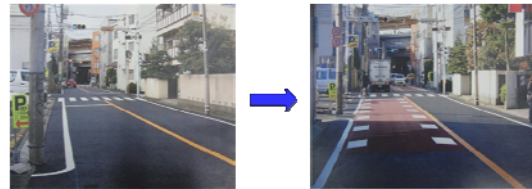
図3：道路ペイントの施工前と施工後
