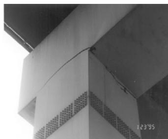
図1 兵庫県南部地震で発生した脆性破壊
