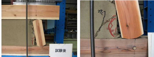
写真 2 土壁の破壊状況
