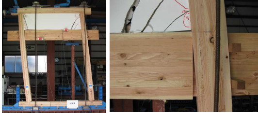
写真 4 垂壁付き独立柱の破壊状況
