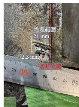
図-5 閉口処理後のき裂状況
