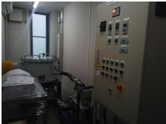
図1 酸化マグネシウムを設置した真空チャンバー
