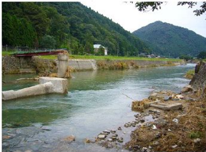
写真-1 2009年佐用豪雨による橋被害
