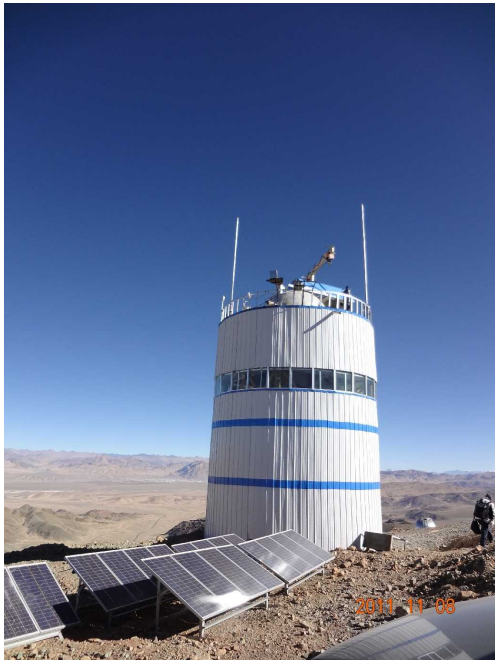
図 2. 天体観測環境評価機材用 10m ドーム。屋上部分に機材が設置された。
