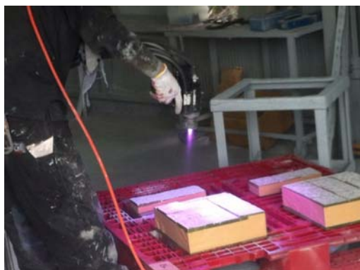
写真1 溶射の施工状況
