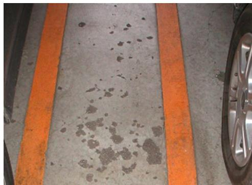
写真 1 自走式駐車場のスケーリング例
