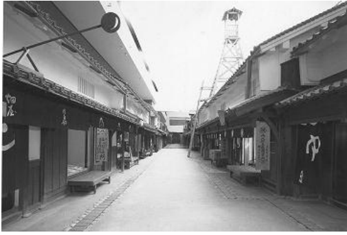
写真1 大阪市立住まいのミュージアムの再現展示（江戸時代の大坂の町並）
