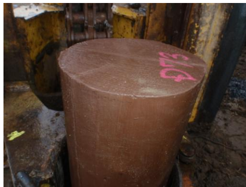
写真-2 重機で圧入後の被覆材の状況
