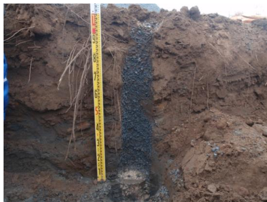
写真-1 施工した被覆土の断面状況
