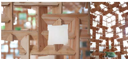
写真4. 錐体卍格子構造の部材と組み合わせ
