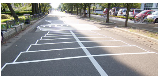
図10上: サイン曲線型ハンプとの融合(仮施工A)
