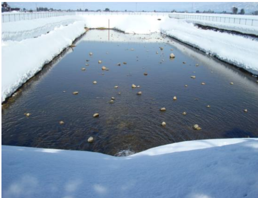
写真2 六郷扇状地の地下水人工涵養池 2012/03/14 (By Hida)
