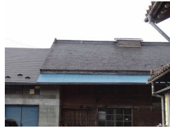
図3-4 遠野の作業屋
