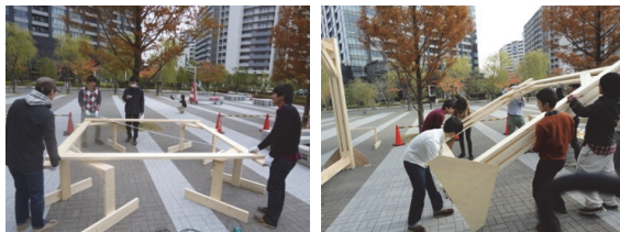
(a)フレームの作成 (b)フレームの立上
