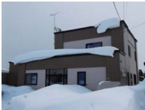
写真2 実測建物外観（北面）
