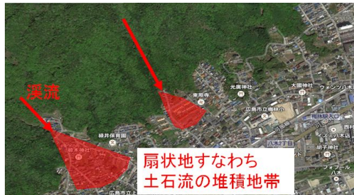
写真1 風化花崗岩斜面の豪雨時崩壊による災害(2014年広島)
