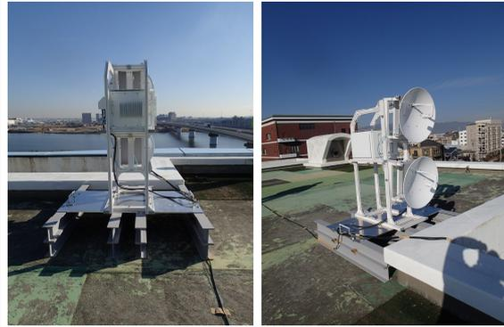
図-7 レーダ設置状況
