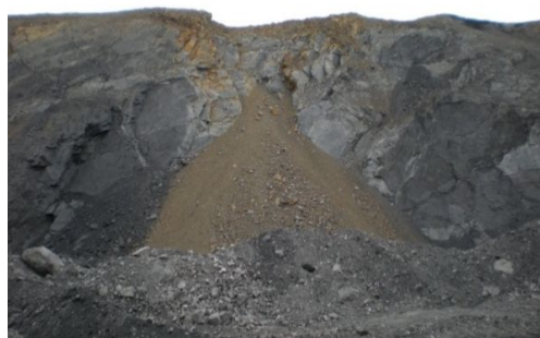
図2 斜面のすべり崩壊の事例
