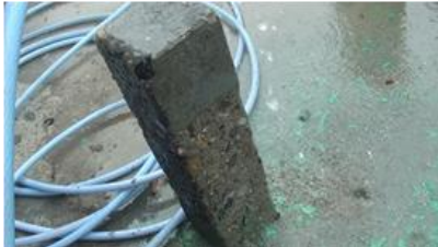
写真8 塗布領域による劣化部進行事例
