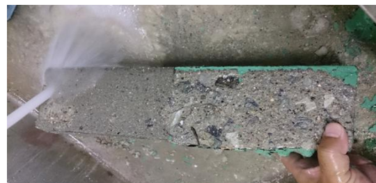
写真7 防水層とコンクリート損傷特性
