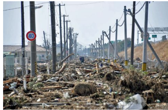
写真-1 2011年東北地方太平洋沖地震の津波被害の状況 (NEXCO 総研提供)
