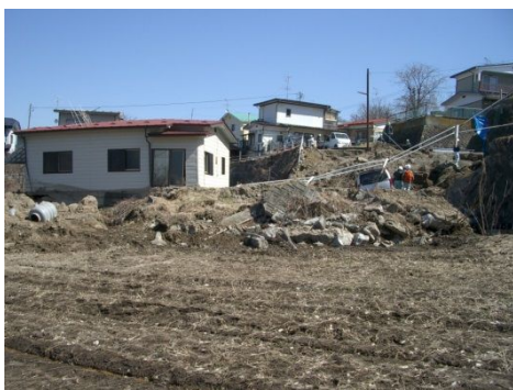
写真1 2011年他東北地方太平洋沖地震時のしらす地盤の泥流状崩壊例
