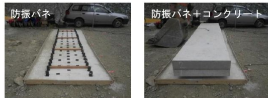
写真1 振動系設置の一例(コンクリートブロック2枚)
