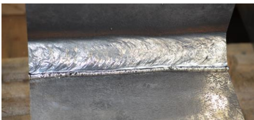
図4 ピーニング施工後の溶接止端の様子
