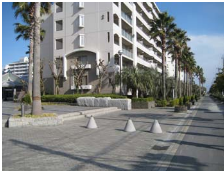
写真 1 ほぼ無被害な地盤改良済集合住宅
