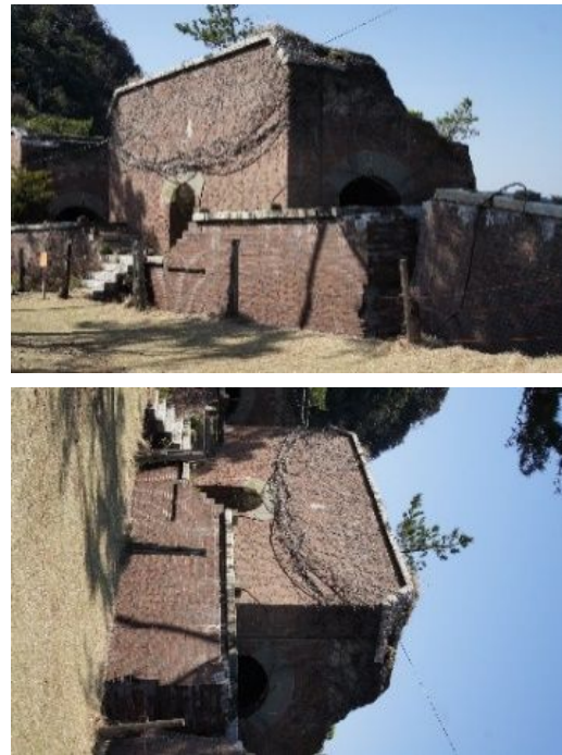
図1 由良要塞:友ヶ島第2砲台跡(上:横位置,下:縦位置)
