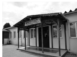
図6 構造材が転用されたチャイバシ村市民ホール
