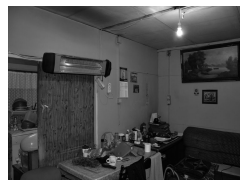
図9 界壁が撤去された居室
