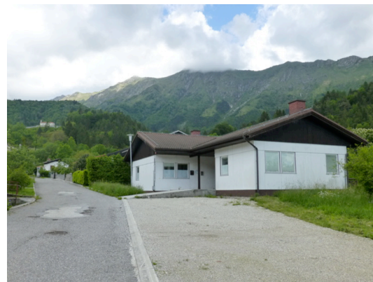
図 5 プレギン村に建設されたプレハブ住宅
