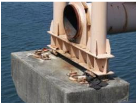
図3 矢の浦水管橋サイドブロックボルトの様子
