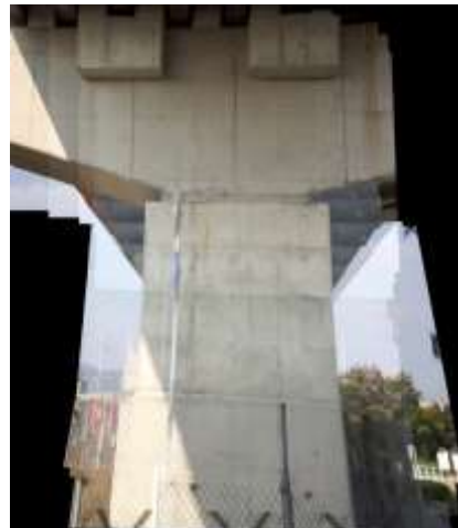
図 4：橋脚の死角補間画像
