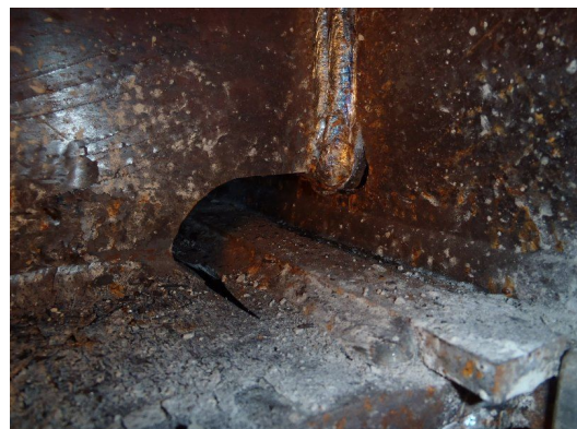
写真3 柱スキンプレートのパンチング(1体目)
