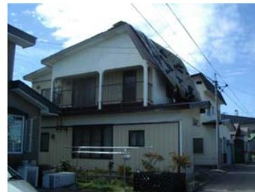
写真3 屋根葺き材の被害例
