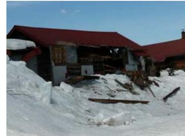
写真2 小屋組の被害例
