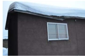
写真1 軒折れの被害例
