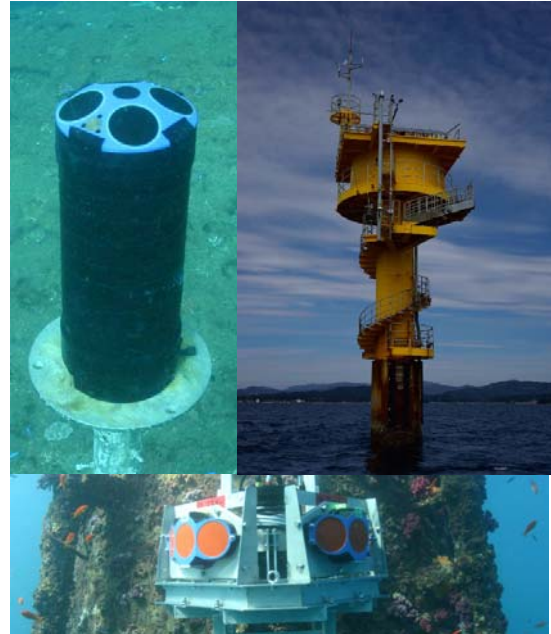
図1: 白浜沖観測塔(右上)、海底設置 ADCP(左上)、観測塔脚部に設置した ADCP(2機)
