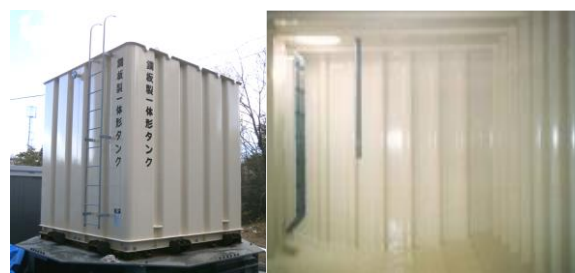
(a) タンクの外観 (b) タンク内部 写真-2 鋼板製一体形タンク
