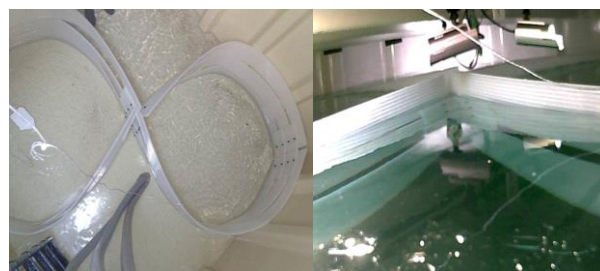
(a) 注水前 (b) 注水後 写真-3 タンク内に浮体式制振装置を設置した状態
