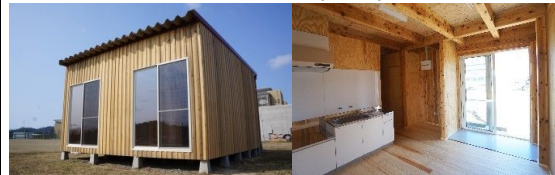
南側外観(居室開口)
