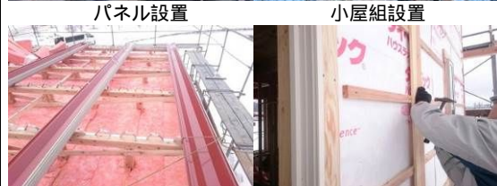
天井断熱・屋根材設置
