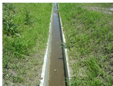
写真-3-3 敷設した PCa 製品(福島県)
