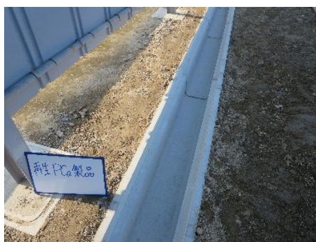
写真-3-1 敷設した PCa 製品(宮城県)
