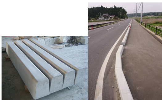
写真-3-2 敷設した PCa 製品(福島県)
