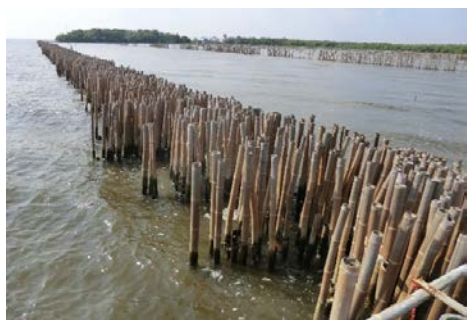
図-7 消波を目的に設置された竹柵
