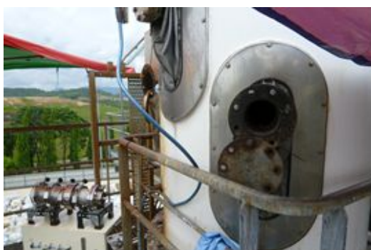
写真2 煙道のサンプリングポートと使用した希釈器
