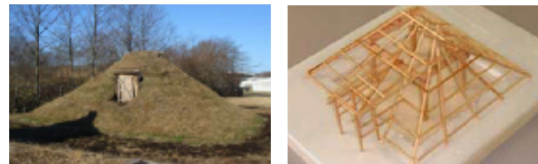
写真2 2期工事完了後のトイチセ(左)
