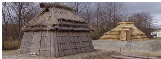
写真1 1期工事完了後のトイチセ(右)とチセ(左)
