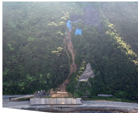
図7 GPS変位計測を実施している急傾斜斜面
