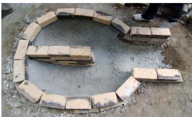
図 8 平面鍵穴型プラン土器焼成窯
