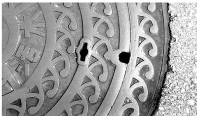
写真1 孔が露出しているマンホールの例
